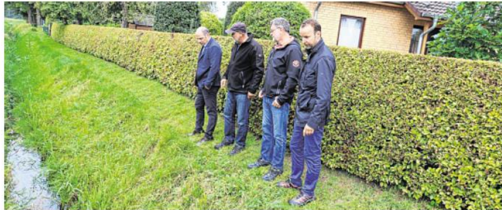
Sieht harmlos aus: der Graben in Hagenow-Heide. Doch hier käme das Wasser von der Straße an und könnte kaum abfließen. Vor-Ort-Termin der Stadt und des Wasser- und Bodenverbandes. FOTO: POHLE
