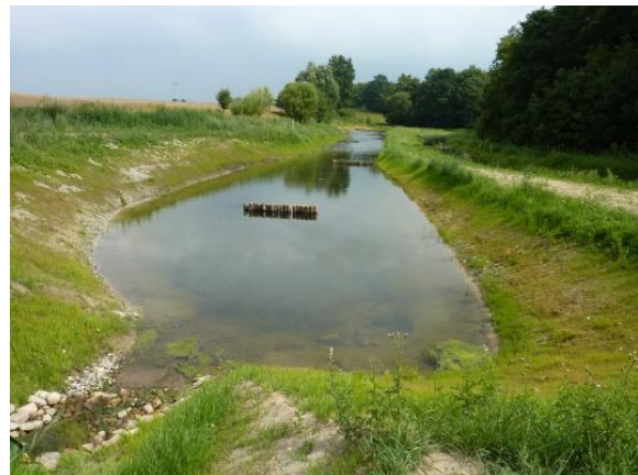
ABBILDUNG 14: BEISPIELE FÜR FLIEßLEITSYSTEME IN DRÄNTEICHEN (LI. QUERBAUWERK, RE. QUER- UND LEITBAUWERKE)
