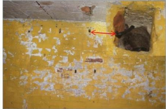
Wasserfledermaus in Wandloch
