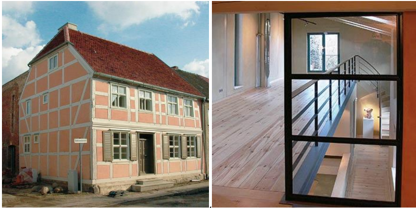
Abb. 52: Beispiel: Umbau eines Ackerbürgerhauses (ehem. Bäckerei mit Laden und Backstube) zu einem Wohnhaus
