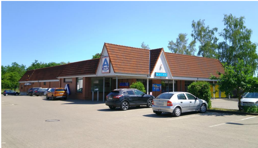
Abb. 23: Aldi im Nahversorgungszentrum Rudolf-Tarnow-Straße
