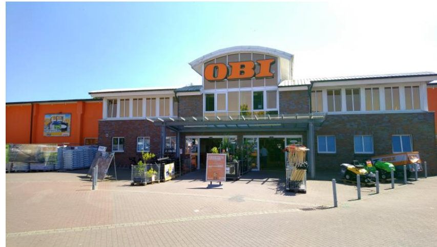
Abb. 34: Obi Bau- und Gartenmarkt, Bahnhofstraße
